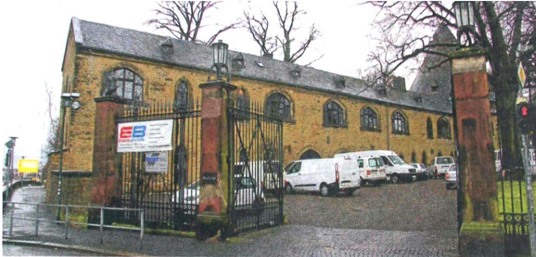
Großaufgebot von Handwerkern: Ein zugeparkter Werderhof-Vorplatz lässt erahnen, dass hinter den historischen Mauern derzeit kräftig um- und eingebaut wird. Fotos: Heine
