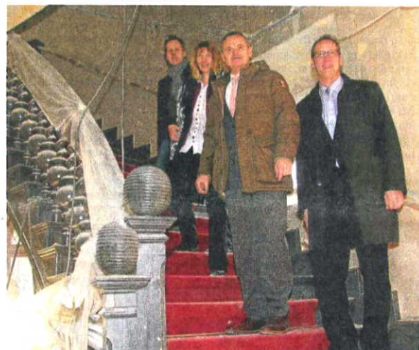
Die Treppe bleibt: Architekt Marco Evers, Hildesheims Krankenhaus-Chefin Birgit Hörke, Ameos-Vorstand Michael Dieckmann und Ex-Starck-Mann Gerald Baehnisch als neuer Ameos-Kommunikationschef für die Region (v.li.) besichtigen die Baustelle.
