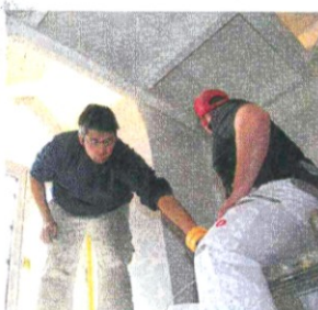
Malern, was das Zeug hält: 2940 Quadratmeter Wände sind zu streichen.
