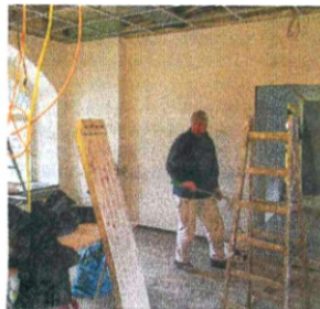
Mächtig zu tun: Kabel in die Decke, Farbe an die Wand.
